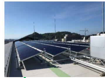
太陽熱集熱器 (太陽熱でお湯をつくる)
